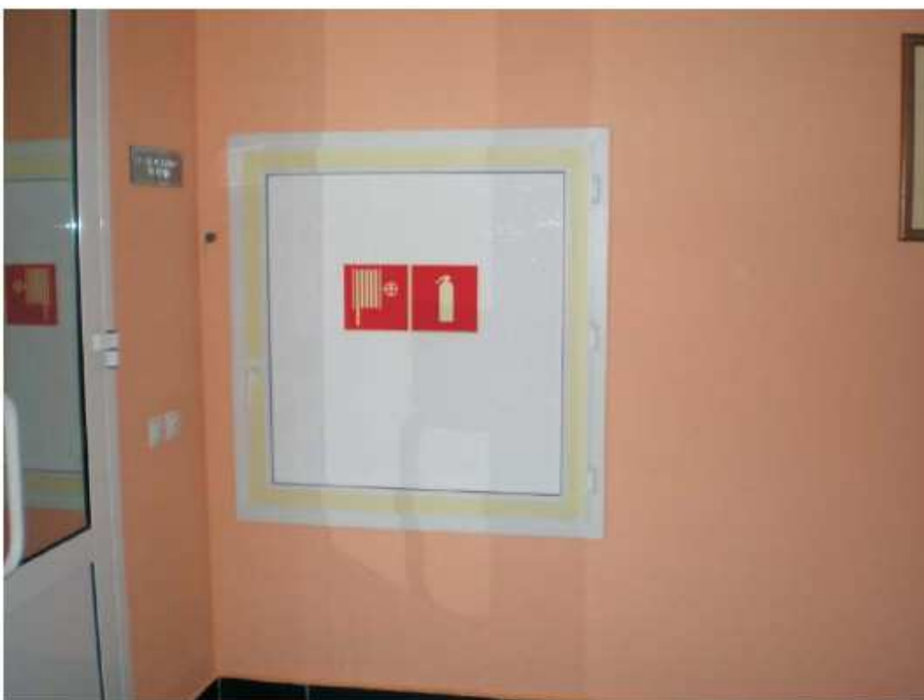
Рисунок А.6 - Обозначение фотолуминесцентной 50-мм лентой контура пожарного оборудования и использование знаков пожарной безопасности
